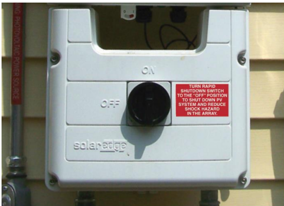
Figura 2 – Exemplo de dispositivo de desligamento rápido. Fonte: Article 690 Solar Photovoltaic (PV) Systems – NFPA 70.
